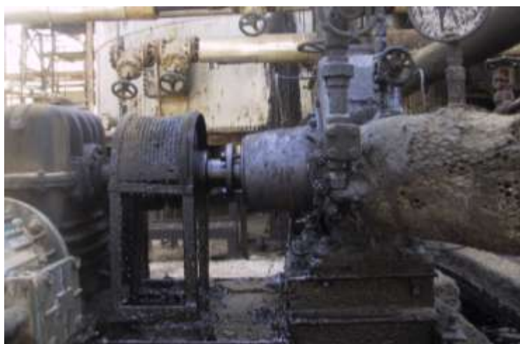
شکل ۱-۳ نمایی از نشتی قیر از پمپ
