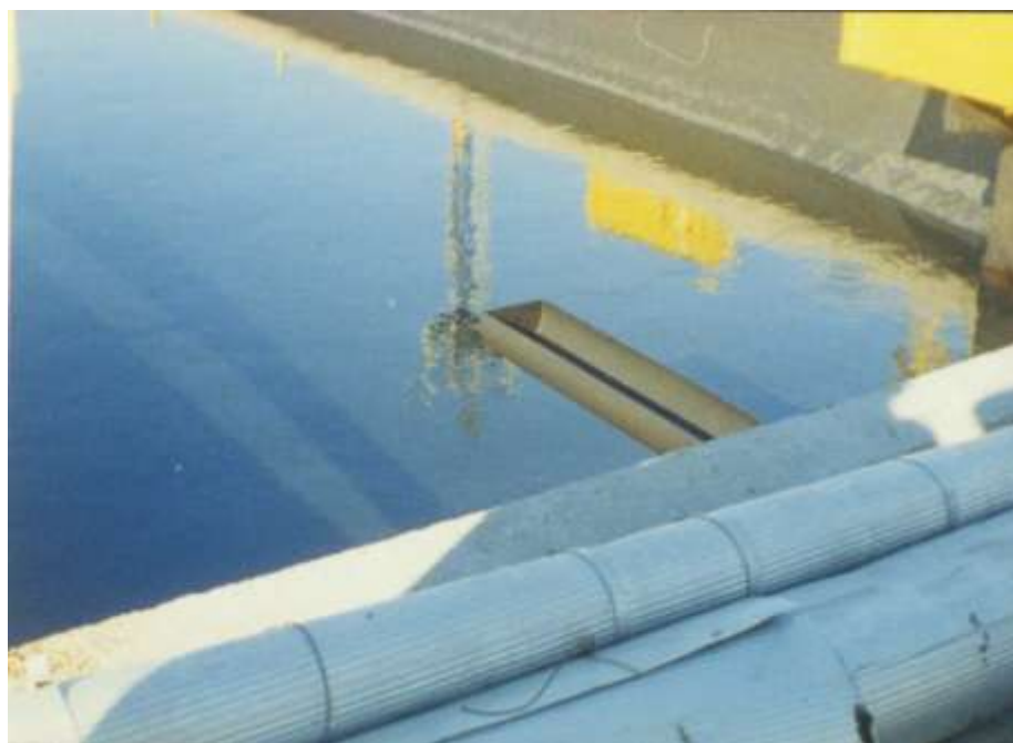
شکل ۵-۶ کانال تعبیه شده جهت زدودن مواد نفتی از روی آب متعادل‌ساز
