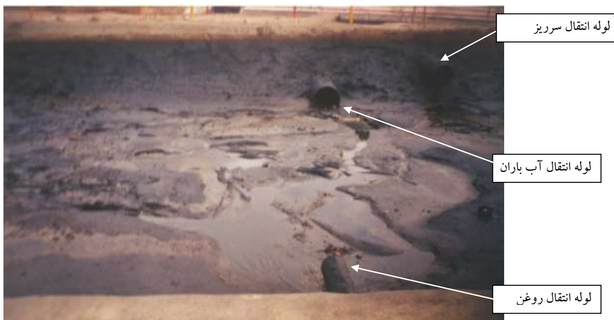
شکل ۶-۸: نمایی از Surge Basin: سه لوله ورودی جهت انتقال آب باران و سرریز API و
