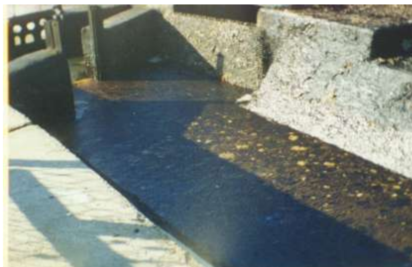
شکل ۶-۷ نمایی از کانال جمع‌آوری آبهای سطحی و آب باران
