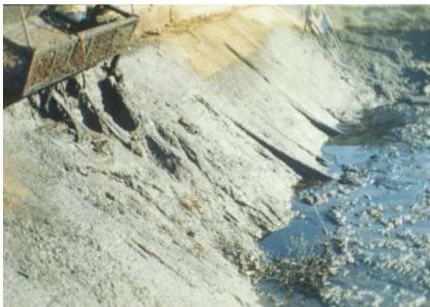
شکل ۶-۹ نمایی از Surge Basin و وسیله مورد استفاده برای تخلیه لجن به جای مانده
