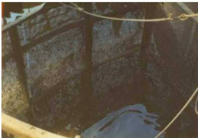
شکل ۳-۶ نمایی از آشغالگیر اضافه شده به دهانه کانال ورودی به API
