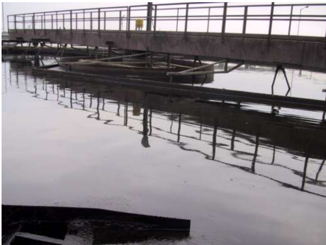
شکل ۳-۵ نمای از پل گردان یک کلاریفایر
