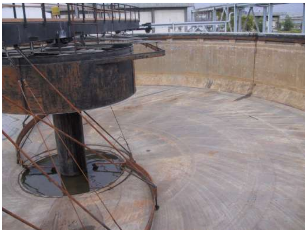
شکل ۳-۴ نمایی داخلی یک کلاریفایر
