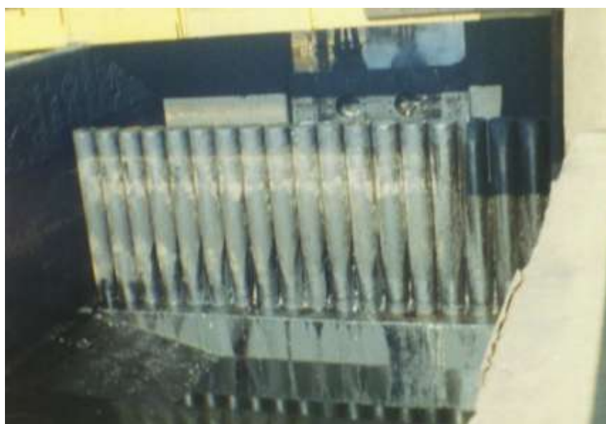
شکل ۴-۶ نمایی از آشغالگیر میله ای
